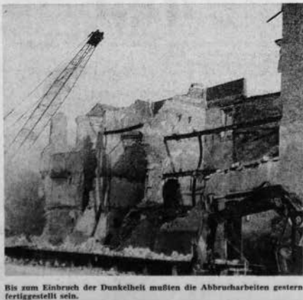
Bis zum Einbruch der Dunkelheit mußten die Abbrucharbeiten gestern fertiggestellt sein.
