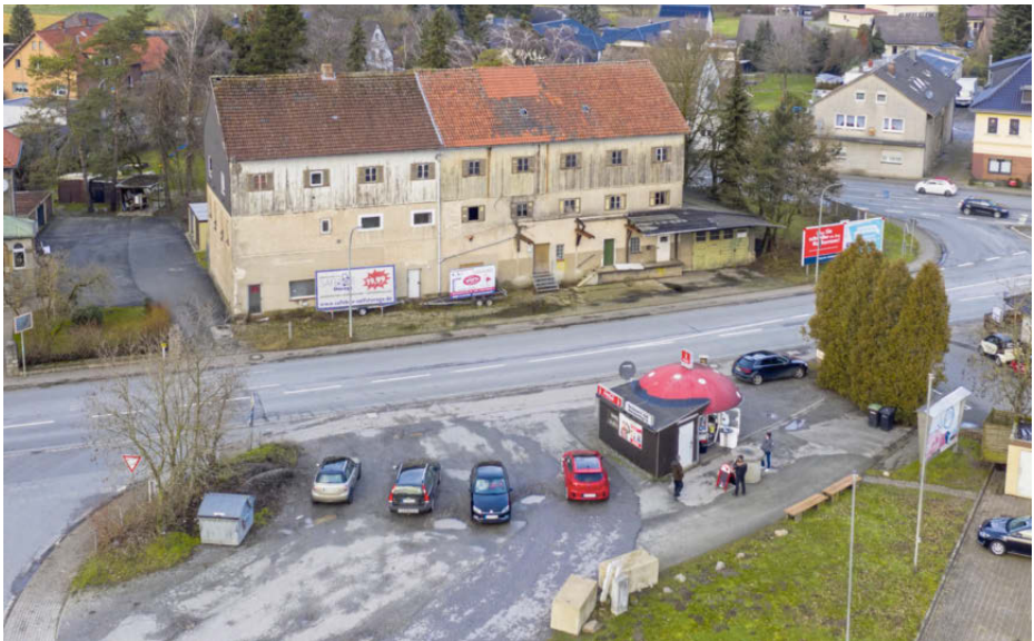
In dieser Woche beginnt der Abriss des alten Kornspeichers am Borgholzhausener Bahnhof. Die dazugehörige Mühle wurde nach einem Brand im Jahr 1975 abgerissen und machte Platz für den legendären Pilz-Imbiss.
